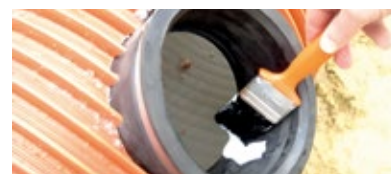
Dichtung innen mit Gleitmittel bestreichen (nicht unter dem Spannband)
