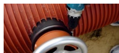
vor Entfernen des Werkzeuges das Spannband mit 8 Nm anziehen
