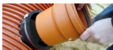
Rohr in die QS-Dichtung einführen
