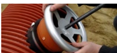
Dichtung mithilfe des Montagewerkzeuges richtig positionieren
