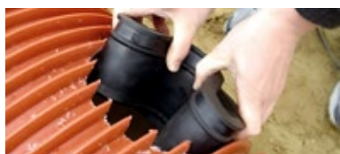
QS-Dichtung im Bohrloch platzieren
