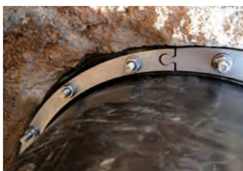
Pressio Individual, geteilt, Trinkwasser, nicht zentrisch
