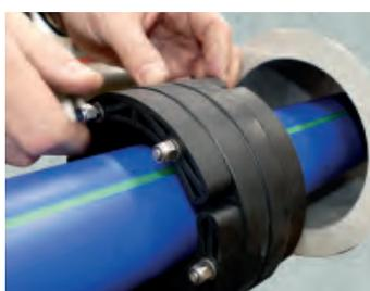
6. Dichtungssatz über dem Mediumrohr wieder montieren.
