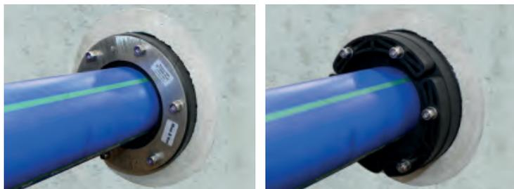
7. Ringraumdichtung in das Futterrohr bzw. die Kernbohrung einfügen.
