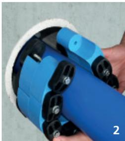
2. **Die Enden der Pressio-Elements verbinden.** Die Schraubenköpfe müssen alle in die Richtung des Monteurs zeigen.
