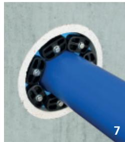
7. Nach ca. 2 Stunden die Schrauben nochmals mit dem angegebenen Drehmoment **nachziehen.** Abhängig von den äußeren Bedingungen (Temperaturen < 10°C, großer Ringraum, usw.) diesen Vorgang mehrmals wiederholen. Dies ist besonders ab IL 500 und größer zu beachten.
