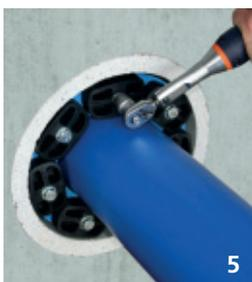
5. Die Schrauben auf 12 Uhr beginnend mit einem **Drehmomentschlüssel anziehen.** Kein Anziehen mit Schlagschraubern!
