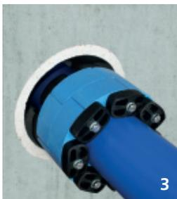
3. Es kann sein, dass die Kette leicht durchhängt. **Es dürfen keine Elemente aus der Kette genommen werden.** Es kann erforderlich sein, dass die Kette bei kleineren Rohrdurchmessern leicht gedehnt werden muss.
