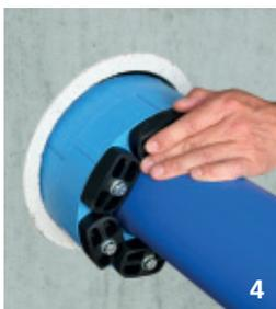
4. Die Pressio Elements **in den Zwischenraum schieben.** Beginnen Sie erst auf 6 Uhr Position, dann rechts und links bis zur 12 Uhr Position. Auch nach dem Einsetzen sollen die Schraubenköpfe gut zugänglich sein.
