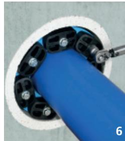
6. Jede Schraube mit ca. 4 bis 5 Umdrehungen anziehen. Diesen Vorgang **im Uhrzeigersinn** so lange wiederholen, bis das angegebene Drehmoment (siehe Tabelle) erreicht ist und der Gummi sich gleichmäßig zwischen den Druckplatten hervor wölbt.
