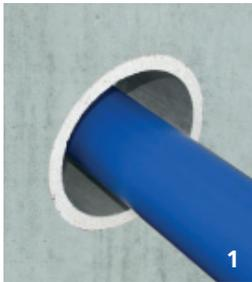
1. **Zentrierung** des Rohres bzw. Kabels in der Mauerhülse/Kernbohrung. Medienrohr bzw. Kabel **muss gelagert** werden. Eine tragende Lagerfunktion können die Pressio-Elements Gliederketten nicht übernehmen.
