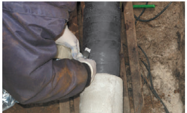
4. Die Enden des PSI Pipecast-Bandes mit Klebeband umwickeln, um die Enden fest an das Rohr zu drücken
