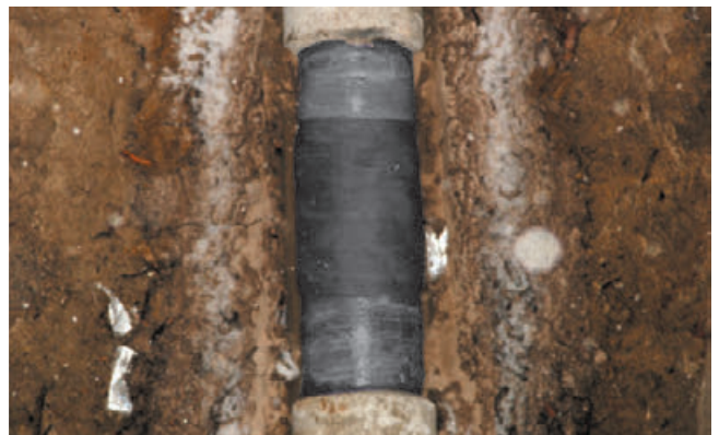
6. PSI Pipecast nach der Pressung
