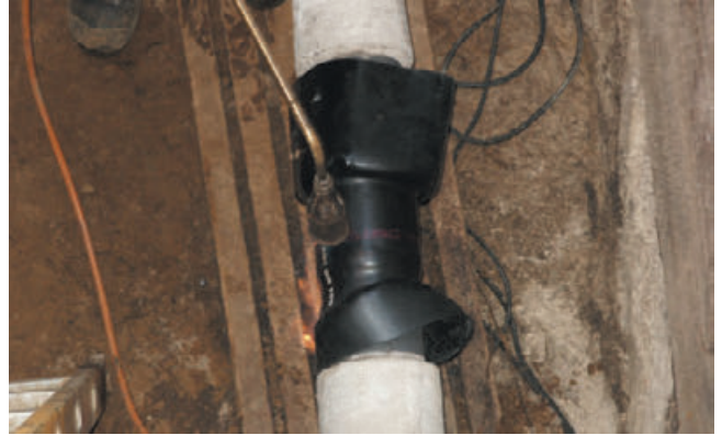
2. Montage des Schrumpfschlauches
