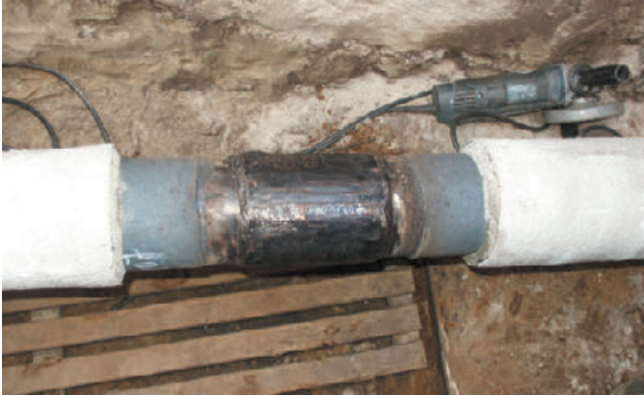
1. Rohrvorbereitung nach GW 15, sauber, trocken und fettfrei. Bei Schrumpfschläuchen-Manschetten, Vorwärmung auf 70°C
