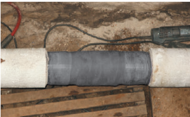
5. Aushärten des PSI Pipecast bei 23°C ca. 20-30 Minuten, einziehbar nach ca. 1 Stunde
