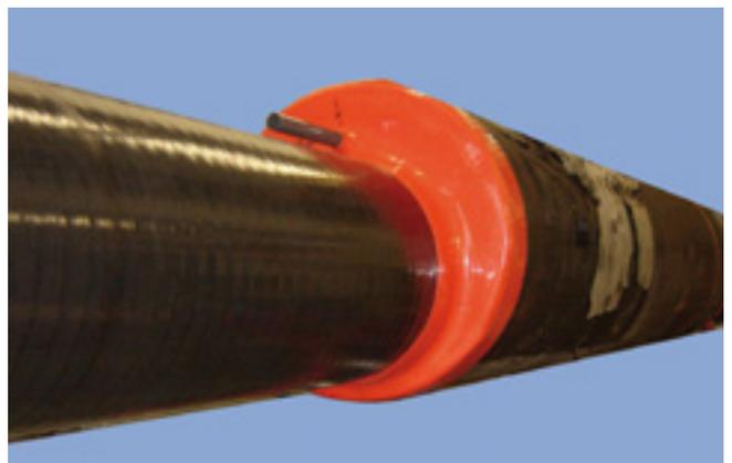
Manschette über Rohre ziehen und Spannbänder (im Lieferumfang enthalten) montieren.
